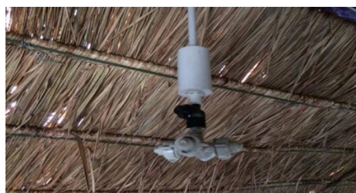
ภาพที่ 2 ติดตั้งหัวพ่นหมอกในโรงเรือนควบคุม
