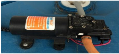
ภาพที่ 3 ติดตั้งปั้มน้ำเข้ากับถังน้ำ 200 ลิตร
