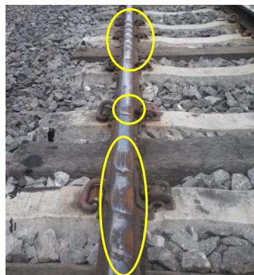
ภาพที่ 1 การสึกหรอจากการเสียดสีของล้อกับผิวหน้ารางรถไฟ
