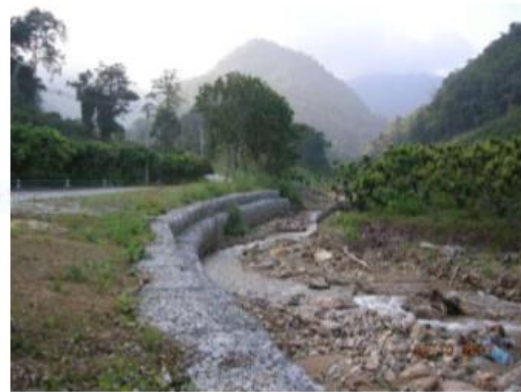
ภาพที่ 18 การใช้ Gabion ป้องกันการกัดเซาะของน้ำบริเวณปลายเชิงลาดคันทาง [18]
