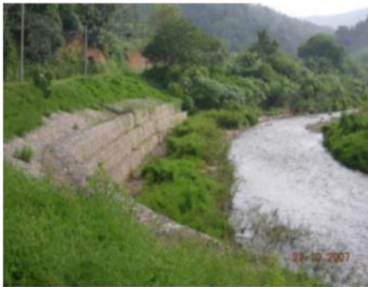
ภาพที่ 18 การใช้ Gabion ป้องกันการกัดเซาะของน้ำบริเวณปลายเชิงลาดคันทาง [18]
