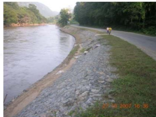
ภาพที่ 19 การใช้ Mattress ป้องกันการกัดเซาะบริเวณเชิงลาดและริมน้ำ [18]
