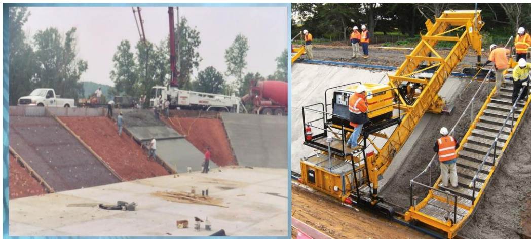
ภาพที่ 21 การใช้คอนกรีตลาด ป้องกันการกัดเซาะบริเวณเชิงลาด [18]
