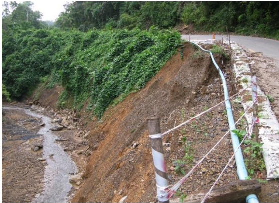
ภาพที่ 3 ลักษณะการวิบัติของลาดคันทาง
