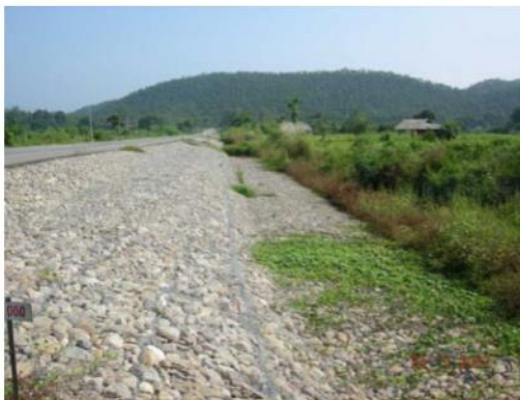
ภาพที่ 19 การใช้ Mattress ป้องกันการกัดเซาะบริเวณเชิงลาดและริมน้ำ [18]
