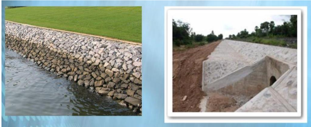
ภาพที่ 20 การใช้หินเรียงยาแนว ป้องกันการกัดเซาะบริเวณเชิงลาด [18]
