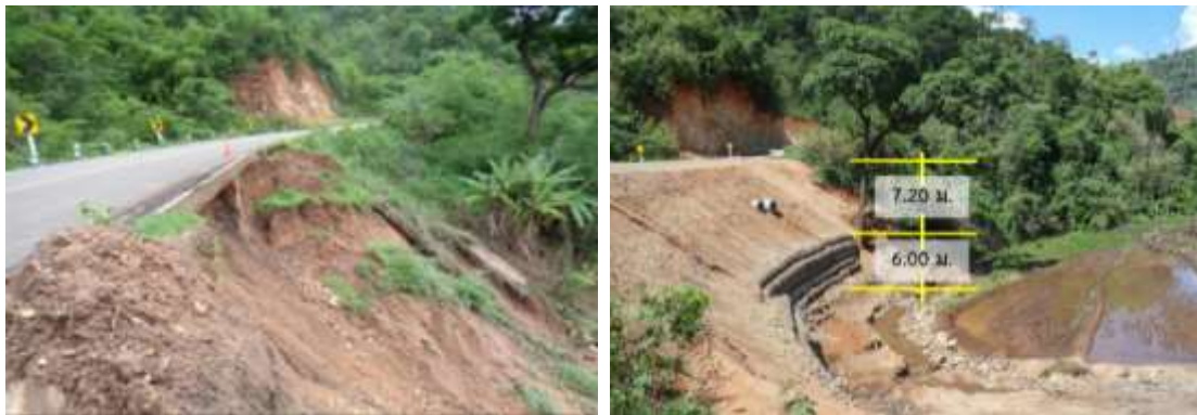
ภาพที่ 1 ความเสียหายจากการกัดเซาะเมื่อปี พ.ศ. 2561 และการบูรณะเมื่อปี พ.ศ.2562 ด้วยการก่อสร้างกำแพงเกวียน (Gabion)
