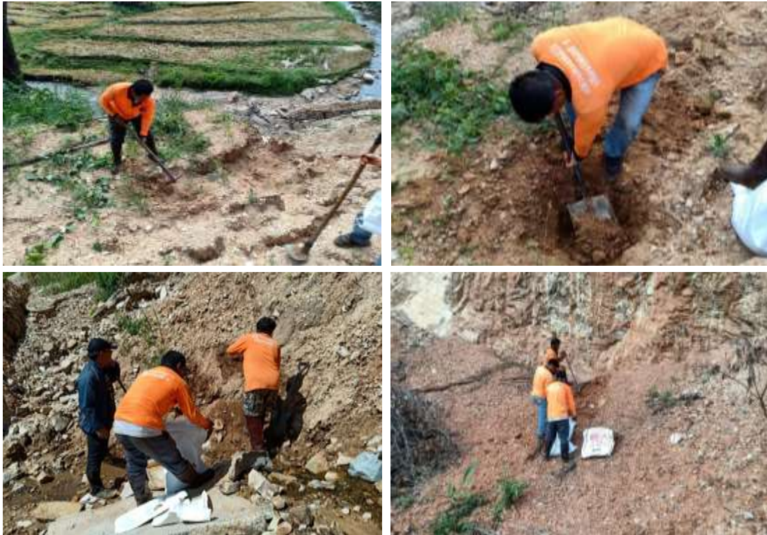
ภาพที่ 7 จุดที่ทำการเก็บตัวอย่างดินด้วยวิธีขุดจากบ่อทดสอบดิน (Test Pit)
