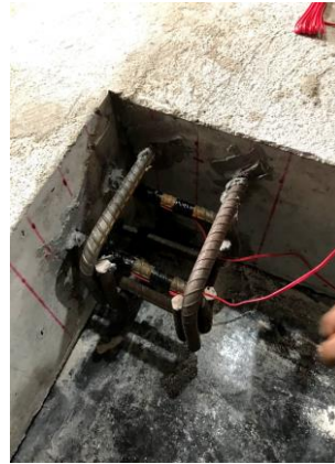
(ข) เจาะเสียบเหล็กเสริม
