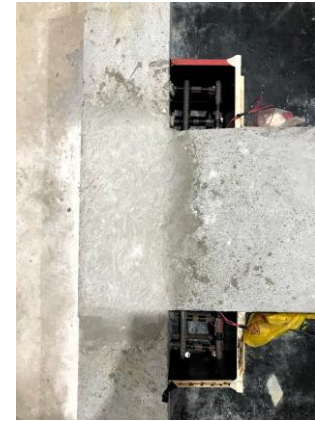
(ค) ประกอบแบบปากคอนกรีต
