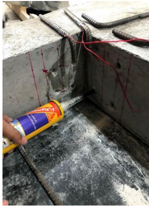
(ก) ฉีด Epoxy ในรูที่เตรียมไว้
