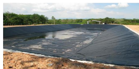
ภาพที่ 14 ภาพ Rubber sheet และภาพตัวอย่างการใช้งานเพื่อป้องกันการซึมของน้ำและการกัดเซาะเชิงลาดจากน้ำ
