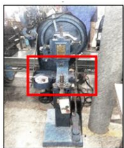
ภาพที่ 1 ก่อนติดตั้งการ์ด
