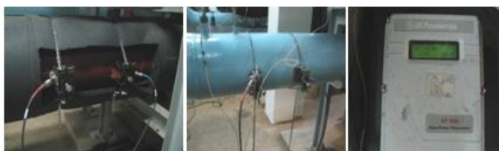
ภาพที่ 3 เครื่องวัดอัตราการไหลของน้ำ (ยี่ห้อ Panametrics รุ่น AquaTrans AT 868)
