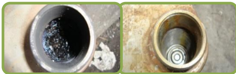
รูปที่ 5 สภาพก่อน - หลังการทำ Flushing
