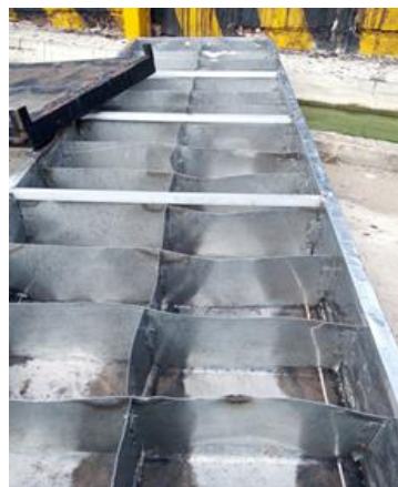
รูปที่ 10 ตะกอกที่ทำความสะอาดและซ่อมแซมแล้ว
