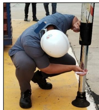
รูปที่ 3 ขั้นตอนการทำเครื่องหมายที่กระบอกสูบ
