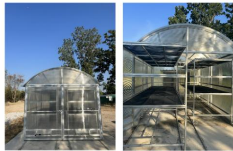
รูปที่ 1 โรงเรือนอบแห้งพลังงานแสงอาทิตย์
