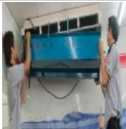
รูปที่ 8 ติดตั้งชุดเครื่องล้างเข้ากับเครื่องปรับอากาศ
