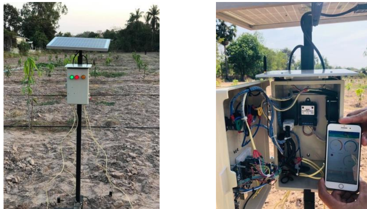
ภาพที่ 8 การติดตั้งและทดสอบระบบ
