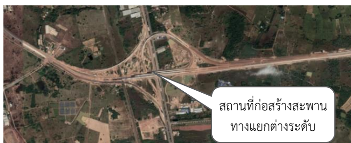
รูปที่ 3 ตำแหน่งที่ทำการศึกษ จุดตัดทางหลวงหมายเลข 2 ตอน น้ำสวย – สะพานมิตรภาพที่หนองคาย (เขตแดนไทย/ลาว) กับทางหลวงหมายเลข 247 ตอน ทางเลี่ยงเมืองหนองคาย (17.812992,102.759076) ที่มา : https://earth.google.com/
