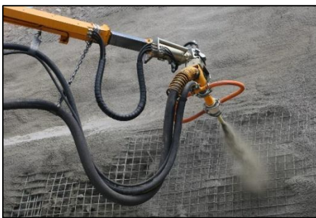
3 (ก) การพ่นคอนกรีต (Shotcrete)
