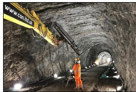
3 (ข) การติดตั้ง Rock Bol
