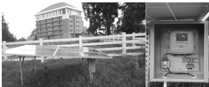
รูปที่ 4 ชุดอุปกรณ์แผงและระบบควบคุมของระบบสูบน้ำเซลล์แสงอาทิตย์
