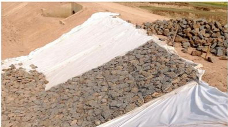
รูปที่ 9 การใช้งานแผ่นใยสังเคราะห์ ( Geotextile )
