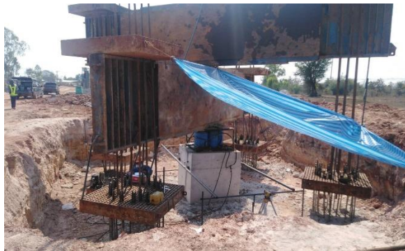
รูปที่ 8 ภาพถ่ายขณะทำการทดสอบการรับน้ำหนักบรรทุก (Static pile load test)
