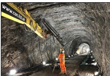
3 (ข) การติดตั้ง Rock Bol
