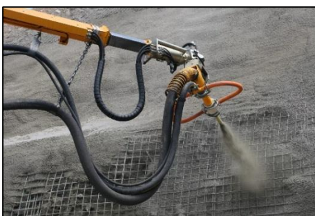
3 (ก) การพ่นคอนกรีต (Shotcrete)
