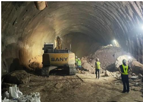
รูปที่ 1 เหตุการณ์ดินทรุดตัวภายในอุโมงค์ ที่มา: Bangkokbiznews. (2024)
