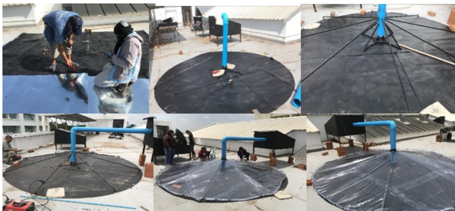
ภาพที่ 3 ขั้นตอนการสร้างระบบรุ่มอบแห้งระหว่างปล่องลมแดดและระบบอบแห้งโดยตรง
