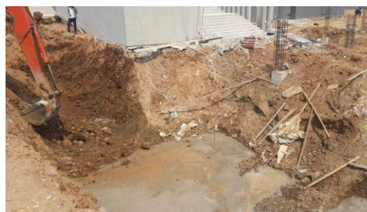
รูปที่ 1 การปรับพื้นที่รองรับอาคารกรมนักเรียนนายเรืออากาศพระองค์ ฯ
