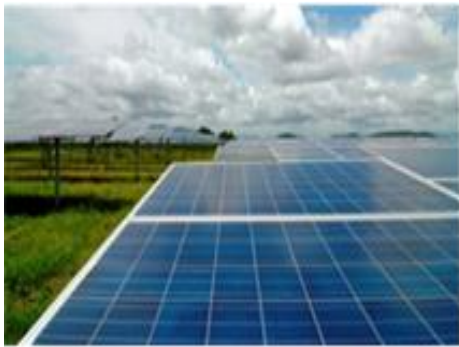
รูปที่ 10 เซลล์แสงอาทิตย์ที่หมุนตามมุมขนานกับพื้น หรือ “ตำแหน่ง Home” ในช่วงเที่ยงวัน [8]
