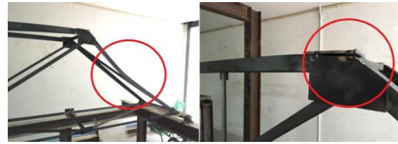
รูปที่ 6 องค์อาคารที่เกิดการวิบัติของสะพานเหล็ก แบบที่ 2 หลังการทดสอบ
