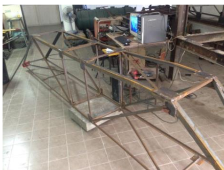
รูปที่ 1 โครงสร้างสะพานเหล็กที่พร้อมก่อนการทดสอบ
