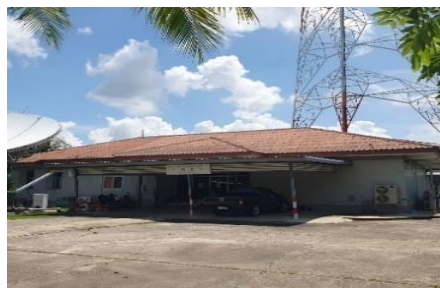
รูปที่ 2 โครงสร้างอาคารเครื่องส่งสัญญาณ สถานีโทรทัศน์ไทยพีบีเอส จังหวัดอุบลราชธานี
