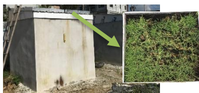
รูปที่ 7 ตัวอย่างการปลูกหญ้าบนหลังคา
