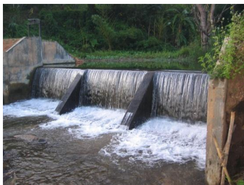
รูปที่ 1 ฝ่ายทดน้ำความยาวสันฝาย 15 เมตร และ งานต่อท่อส่งน้ำที่ได้รับการสนับสนุนแรงงานจากชาวบ้าน
