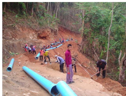
รูปที่ 1 ฝ่ายทดน้ำความยาวสันฝาย 15 เมตร และ งานต่อท่อส่งน้ำที่ได้รับการสนับสนุนแรงงานจากชาวบ้าน
