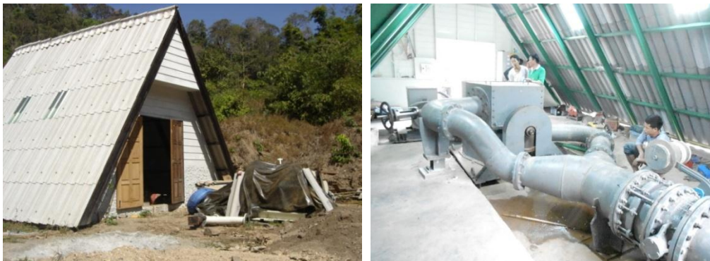
รูปที่ 2 งานก่อสร้างโรงไฟฟ้า และงานติดตั้งเครื่องกั้นน้ำและเครื่องกำเนิดไฟฟ้า
