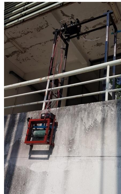
ภาพที่ 2 แสดงระบบชักรถตัวขัดอาคาร (ก) ลักษณะการติดตั้ง (ข) การใช้งานจริง
