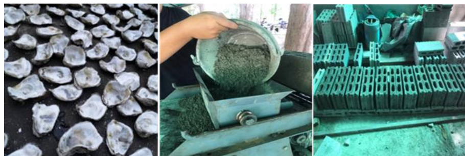
ภาพที่ 3 การขึ้นรูปคอนกรีตบล็อกผสมขยะจากเปลือกหอยนางรมบด
