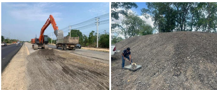
ภาพที่ 4 การเก็บตัวอย่างแอสฟัลต์คอนกรีตเก่า (RAP)
