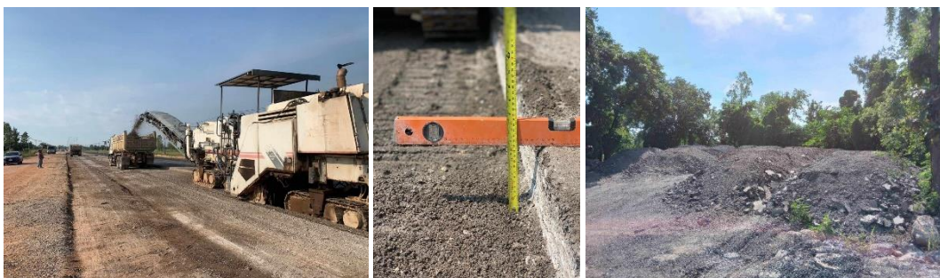
ภาพที่ 1 แอสฟัลต์คอนกรีตเก่า (Reclaimed asphalt pavement, RAP)
