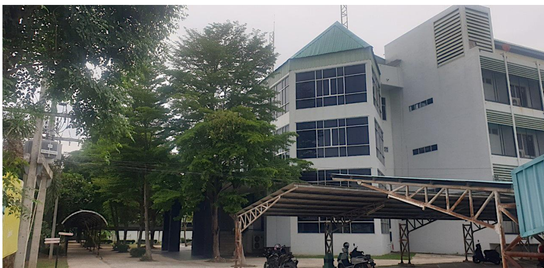
ภาพที่ 2 ภาพถ่ายอาคารเรียนรวม คณะเทคโนโลยีอุตสาหกรรม
