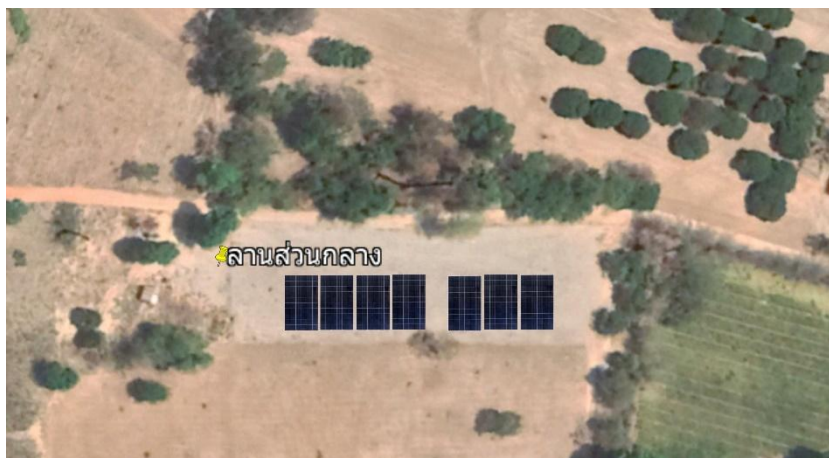
ภาพที่ 4 พื้นที่ติดตั้ง ลานส่วนกลางหรือลานอเนกประสงค์
