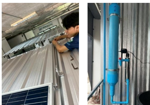
ภาพที่ 4 การติดตั้งแผงโซลาเซลล์และระบบกรอง
