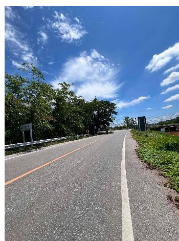
ทางหลวงชนบท พล.2043 (กม.0+200)
