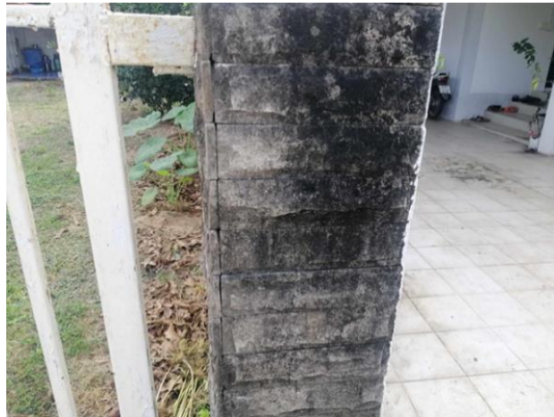
ภาพที่ 1 กระเบื้องหินทรายตกแต่งเสาที่เกิดความเสียหายจากคราบต่าง ๆ
