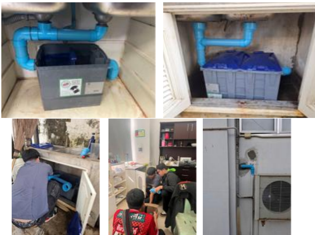
ภาพที่ 2 การดำเนินการติดตั้งถังดักไขมัน
