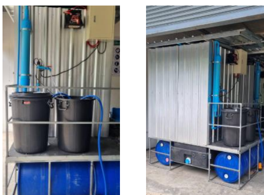
ภาพที่ 5 การติดตั้งอุปกรณ์ในส่วนต่างๆ
