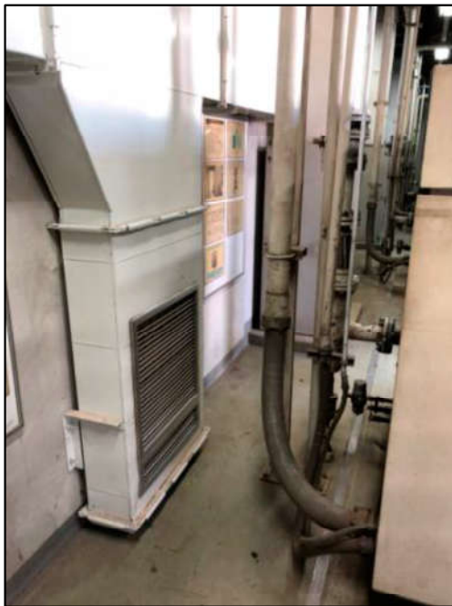
ภาพที่ 6 การวางท่อดูดอากาศในห้องอัดอากาศ
