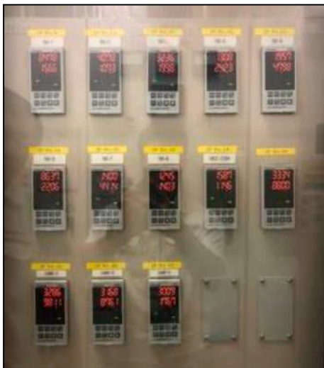
ภาพที่ 4 เครื่องวัดการใช้พลังงานไฟฟ้า
