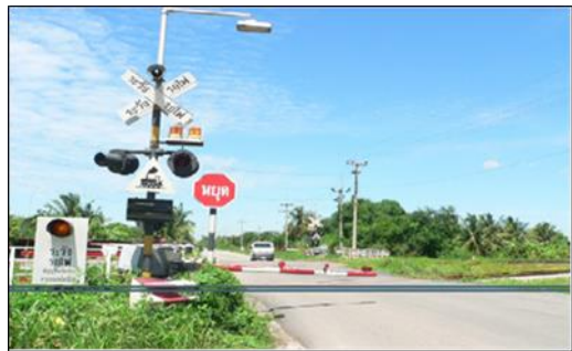
ภาพที่ 3 ตัวอย่างจุดตัดทางรถไฟแบบมีเครื่องกั้น [2]
