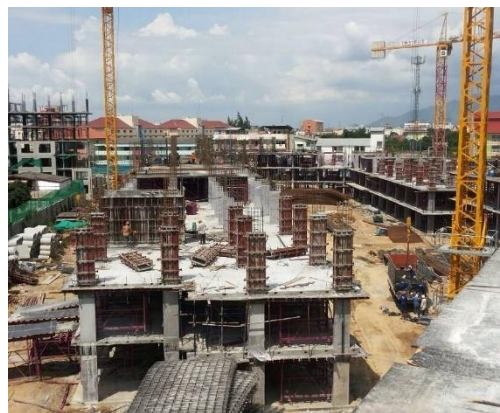
ภาพที่ 10 แบบหล่อเสาที่ใช้ในการทดสอบ
