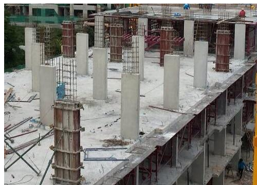
ภาพที่ 12 ผลงานเสาคอนกรีตที่ได้จากใช้แบบหล่อที่พัฒนาแล้ว
