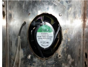
ภาพที่ 15 แสดงการติดตั้งตู้ควบคุมการทำงาน และพัฒนาระบายความร้อนมอเตอร์
