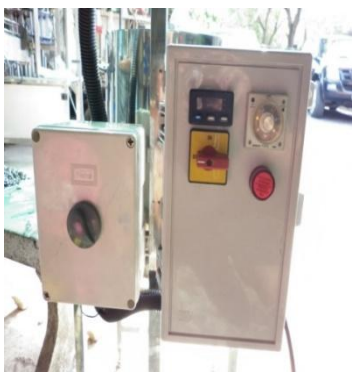
ภาพที่ 14 แสดงการติดตั้งตู้ควบคุมการทำงาน และพัฒนาระบายความร้อนมอเตอร์
