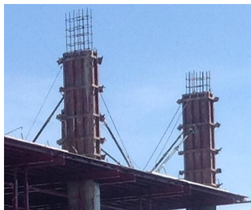
ภาพที่ 11 การค้ำยันแบบต้นด้วยเสาเหล็กปรับเกลียว และตึงด้วยลวดสลิง
