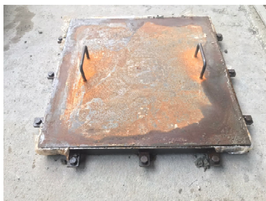
(ข) ปีบอัดมอร์ตาร์ด้วยแผ่นเหล็ก
