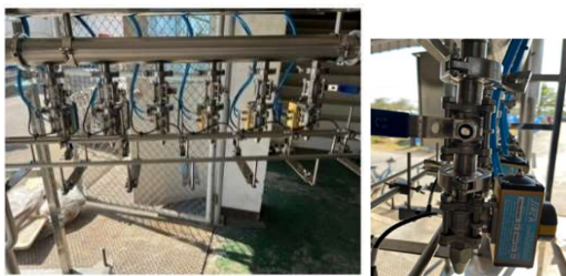
รูปที่ 9 ติดตั้ง Control valve
