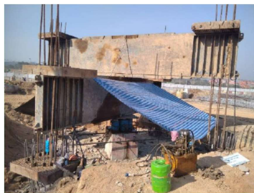
รูปที่ 5 การทดสอบน้ำหนักรับทุกเสาเข็มขนาด 1.00 (ภาพถ่ายเมื่อวันที่ 2 ก.พ. 2564)
