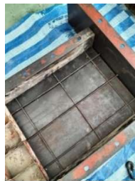
(ก) การเตรียมแผ่นผนังคอนกรีตเสริมเหล็ก
