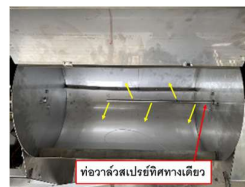
ค. การติดตั้งท่อวาล์ว
