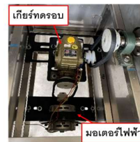
ก. การติดตั้งมอเตอร์
