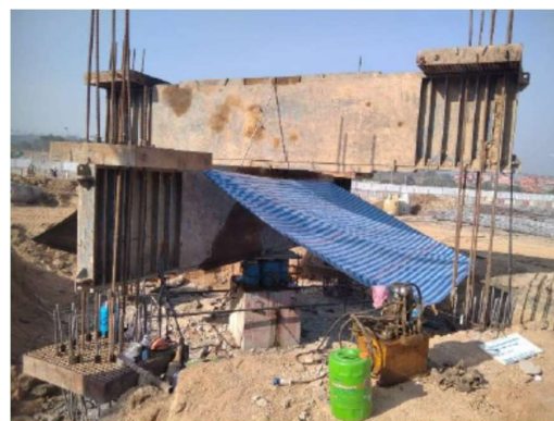
รูปที่ 5 การทดสอบน้ำหนักบรรทุกทุกเสาเข็มขนาด 1.00 (ภาพถ่ายเมื่อวันที่ 2 ก.พ. 2564)
