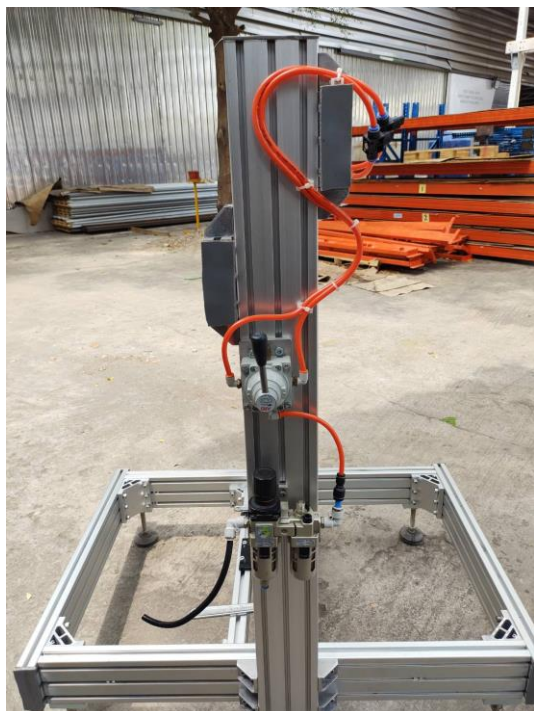
(จ) ติดตั้งตัว Regulator และเดินสายลม
