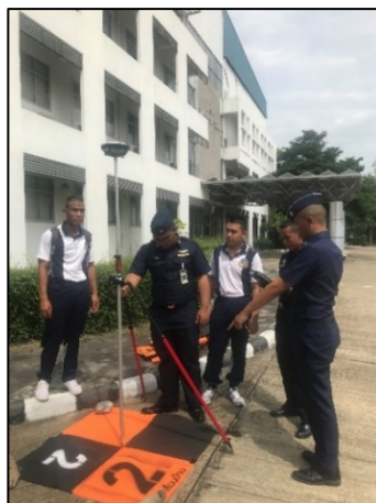
ภาพที่ 2 เตรียมเป็นจุดควบคุมพิกัดอ้างอิงบนพื้น
