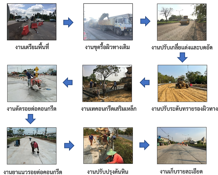
ภาพที่ 4 ขั้นตอนการก่อสร้างถนนคอนกรีตเสริมเหล็ก ถนนสาย นย. 2011
