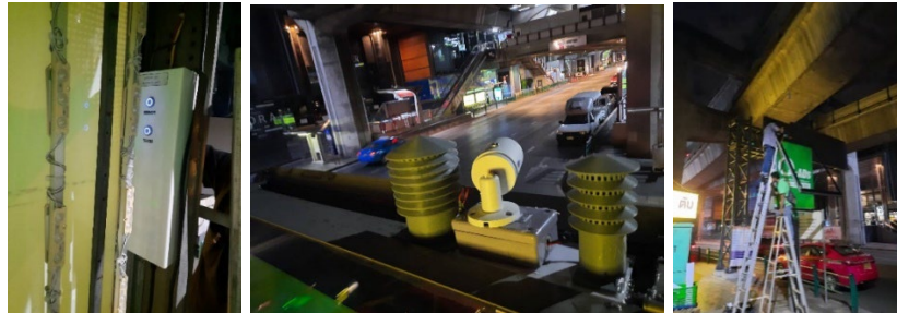
ภาพที่ 13 การติดตั้งและทดสอบการใช้งานอุปกรณ์และระบบในพื้นที่จริง
