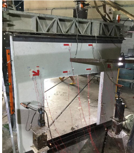
ภาพที่ 5 แสดงอุปกรณ์วัดค่าที่ถูกติดตั้ง
